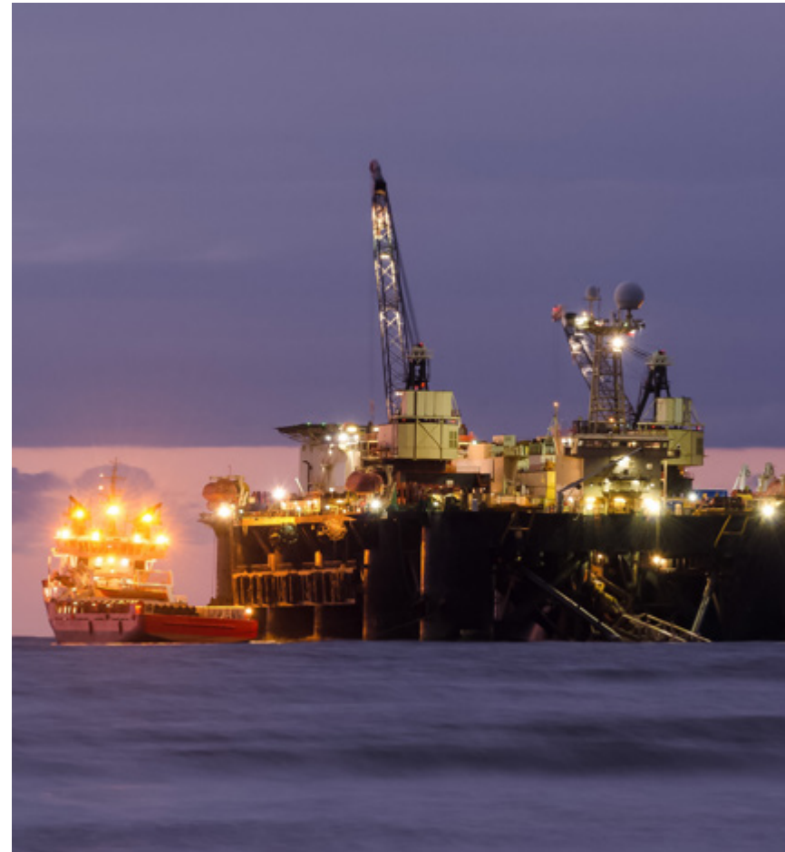
Foto: Trabajos en el mar en la construcción de un gasoducto, Shutterstock.
